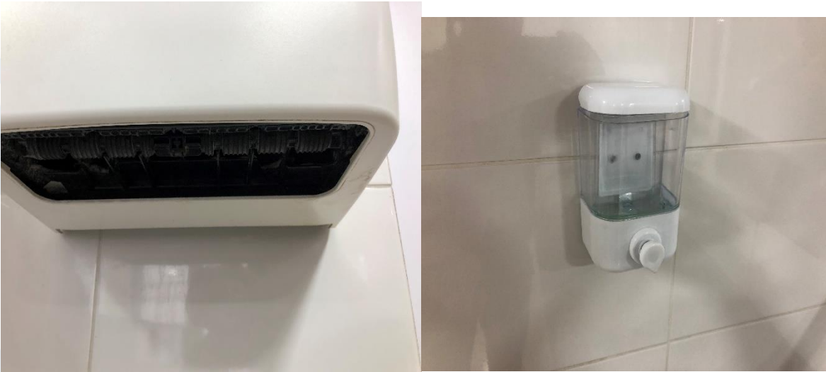
Fuente: Equipo auditor. Baños tercer piso Edificio Alcaldía
