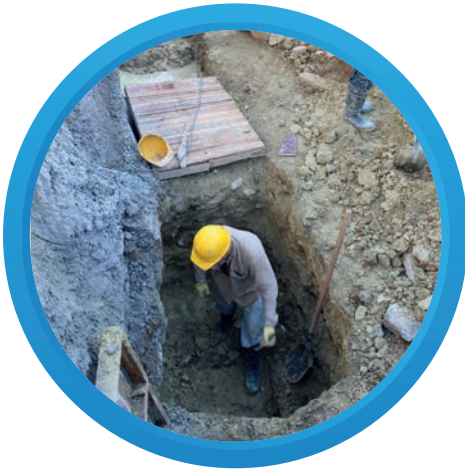
Estamos construyendo redes de acueducto y alcantarillado en diferentes sectores por valor de 2.500 millones de pesos.
