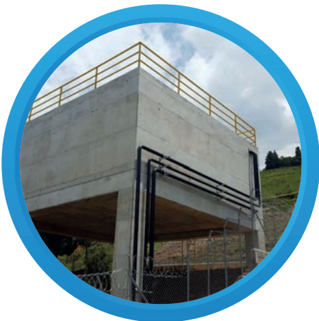
Adelantamos la construcción del tanque de acueducto en la Loma de Los Zuleta por valor de 600 millones de pesos, que beneficiará a 196 familias con el servicio de agua potable.
