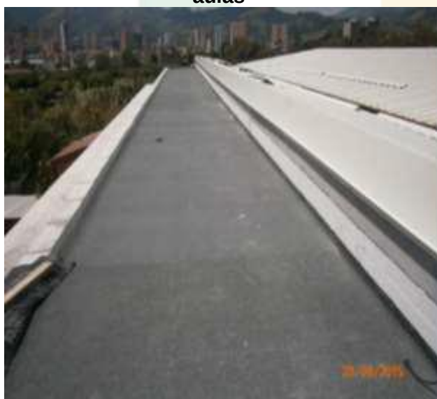
Colocación de manto granulado para impermeabilización de losa de cubierta
