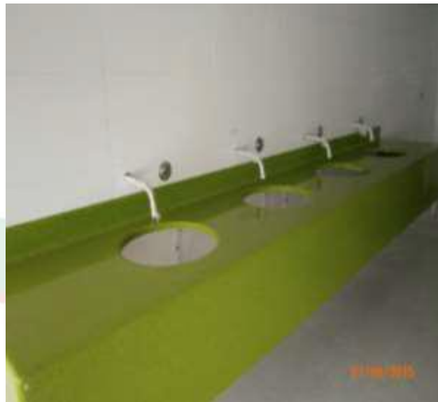
Instalación de mesones en baños
