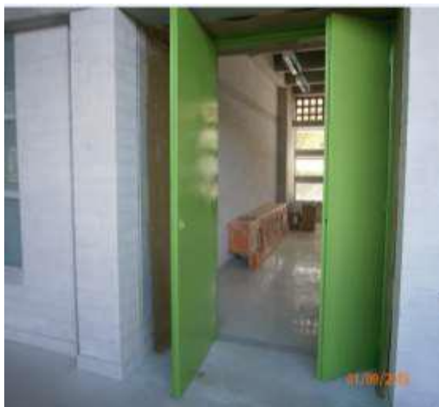
Aplicación pintura en puertas acceso de aulas
