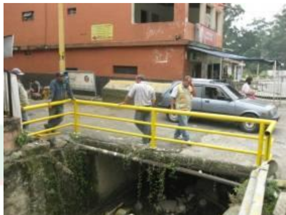
Instalación de barandas de protección calle 48 entre carreras 57ª Y 58
