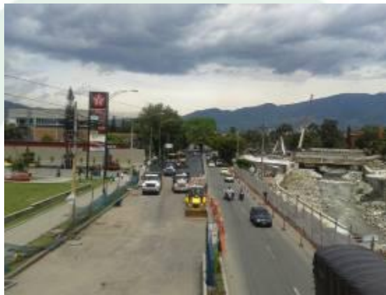
Reconstrucción carrera 52 Av. Santa María entre calles 60 y 63
