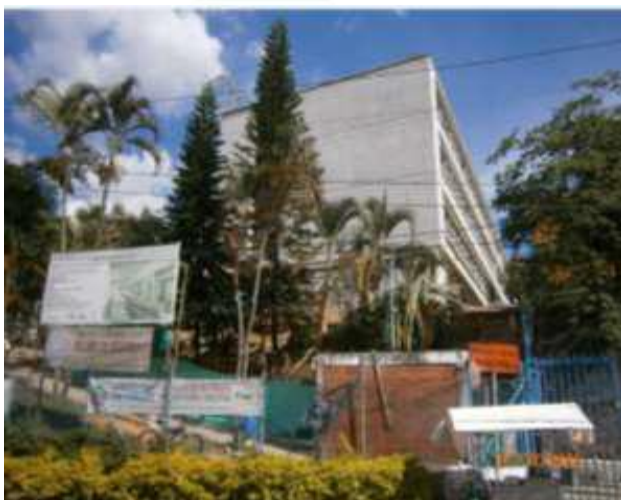
Panorámica de la obra
