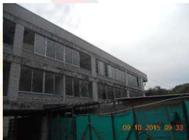
Fachada de estructura 7 existente
