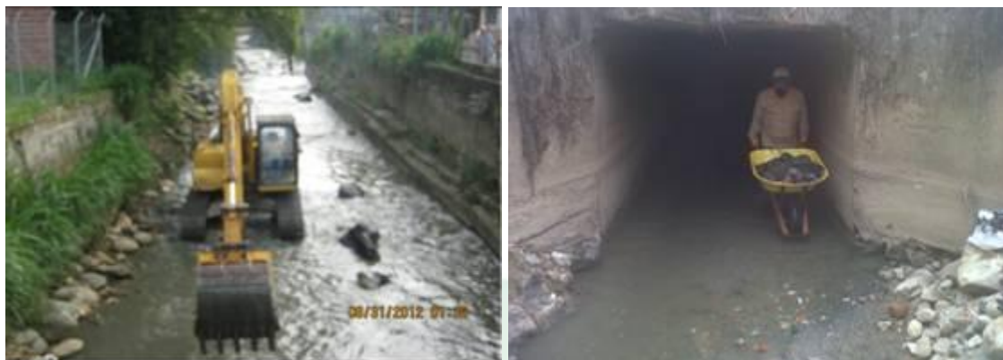
Limpieza manual y mecánica realizada
