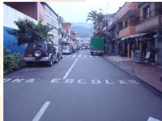
Señalización calle 49 entre carreras 47 y 48 (Posterior a rehabilitación de vía)
