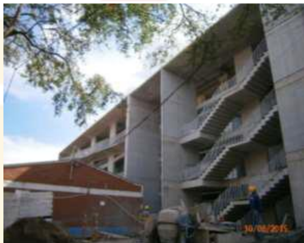
Fachada oriental de la obra
