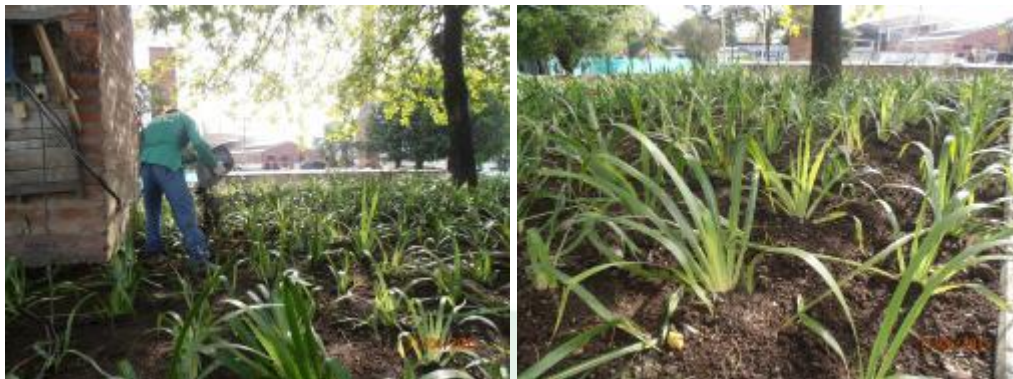
Instalación de coberturas Pasto San Agustín y Mala Madre.
