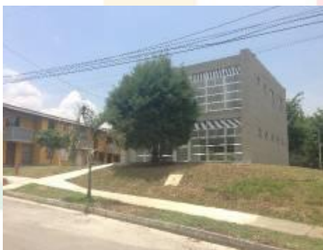
Sede JAC Urbanización Estacion del Sur
