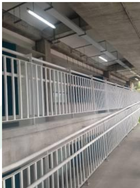
Rampas de acceso. Corredores, fachadas
