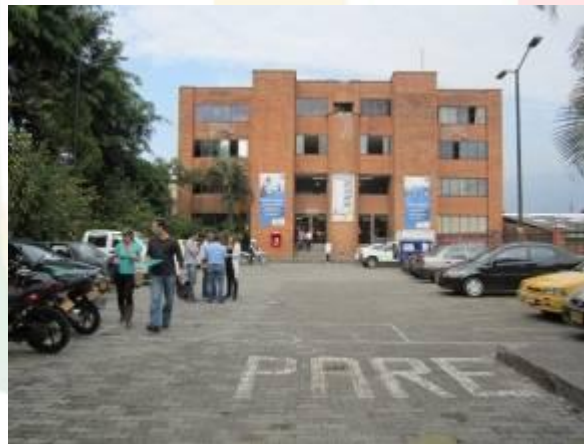
Estado inicial de la infraestructura del Tránsito Municipal Sótano del Tránsito Municipal
