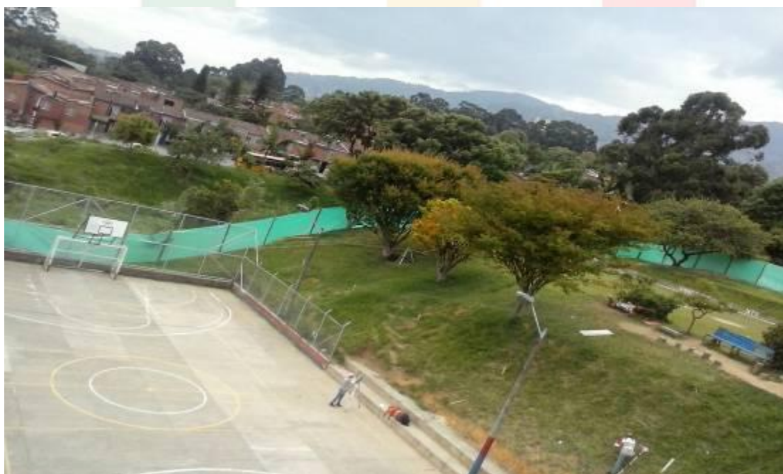
Estado Actual Cancha san Francisco
