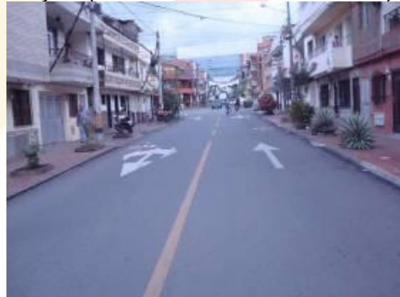
Señalización carrera 47 entre calles 43 y 44 (Posterior a rehabilitación de vía)
