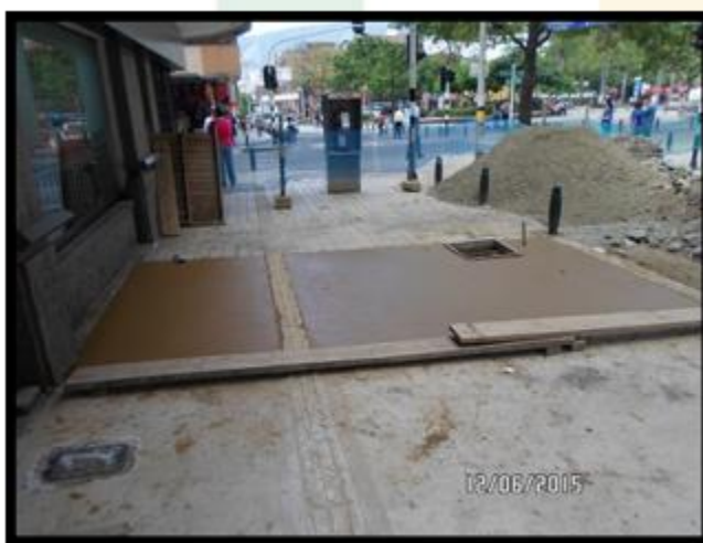
Vaciado de andenes en concreto color en la carrera 51 entre calles 49 y 50 costado occidental.
