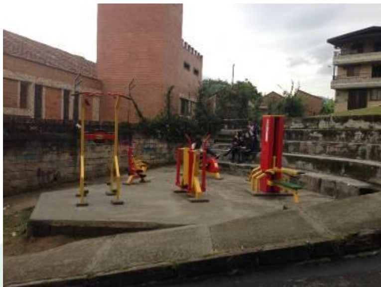
Construcción de Gimnasio al aire libre en el Barrio La Aldea
