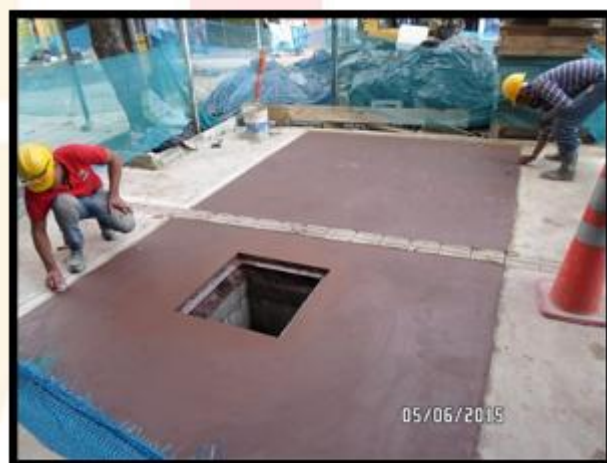
Vaciado de andenes en concreto color en la carrera 51 entre calles 49 y 50 costado occidental.
