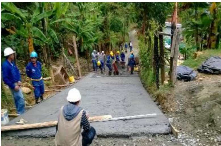
Vereda El Pedregal Lote Municipio
