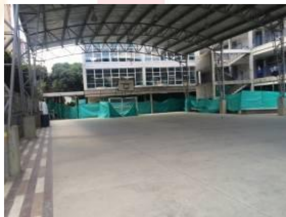
Placa Polideportiva Cubierta - Hoy
