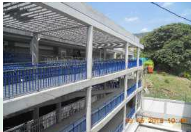
Pasamanos en rampa
