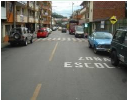
Señalización carrera 47 entre calles 51 y 52 (Posterior a rehabilitación de vía)
