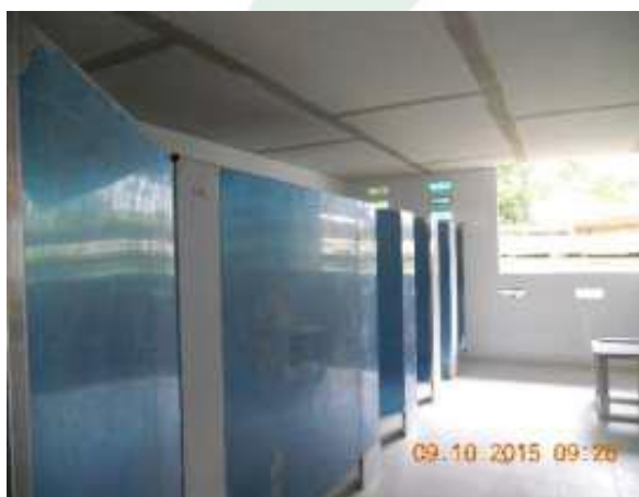
Unidades sanitarias nivel 1 bloque 3
