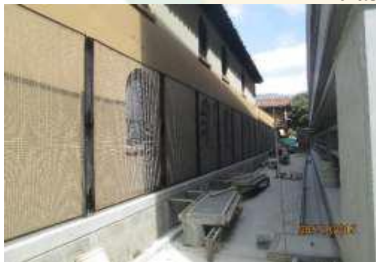
Construcción muros de cerramiento
