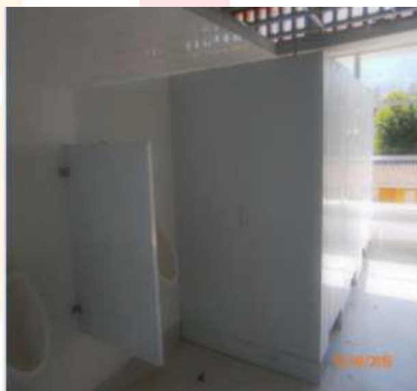
Instalación de divisiones en acero inoxidable en baños
