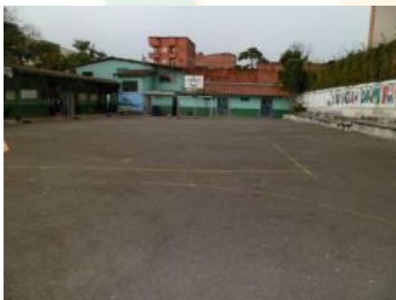
Placa Poliderportiva Antes
